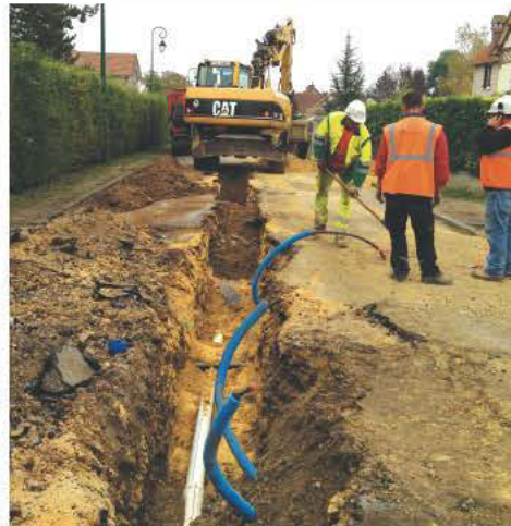
Passage des fourreaux
