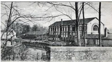
Vue générale de l'usine électrique de Saussay
