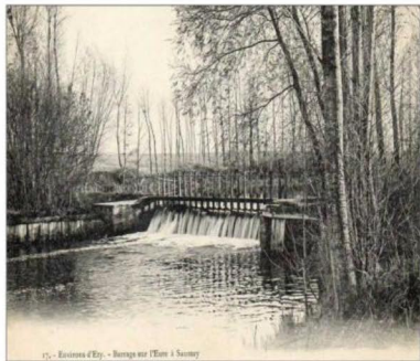
27. - Bassins d'Éry - Barrage sur l'Ère à Saussay
